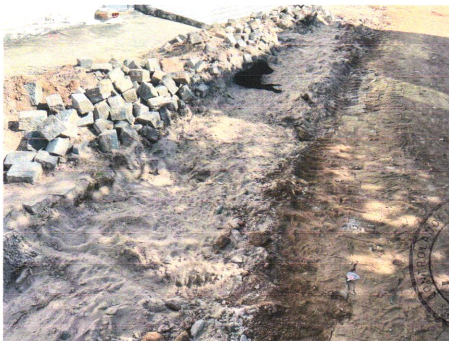
Foto 04 - ATERRO MANUAL COM SOLO ARGILO-ARENOSO IMPORTADO E COMPACTAÇÃO MECANIZADA EM CAMADAS DE 0,20 M NO MÁXIMO
