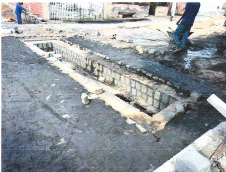
Foto 06 – ALVENARIA DE BLOCOS DE CONCRETO ESTRUTURAL 14X19X39 CM, (ESPESSURA 14 CM) FBK = 14,0 MPA, PARA PAREDES COM ÁREA LÍQUIDA MENOR QUE 6M 2 , SEM VÃOS, UTILIZANDO PALHETA. AF_12/2014
