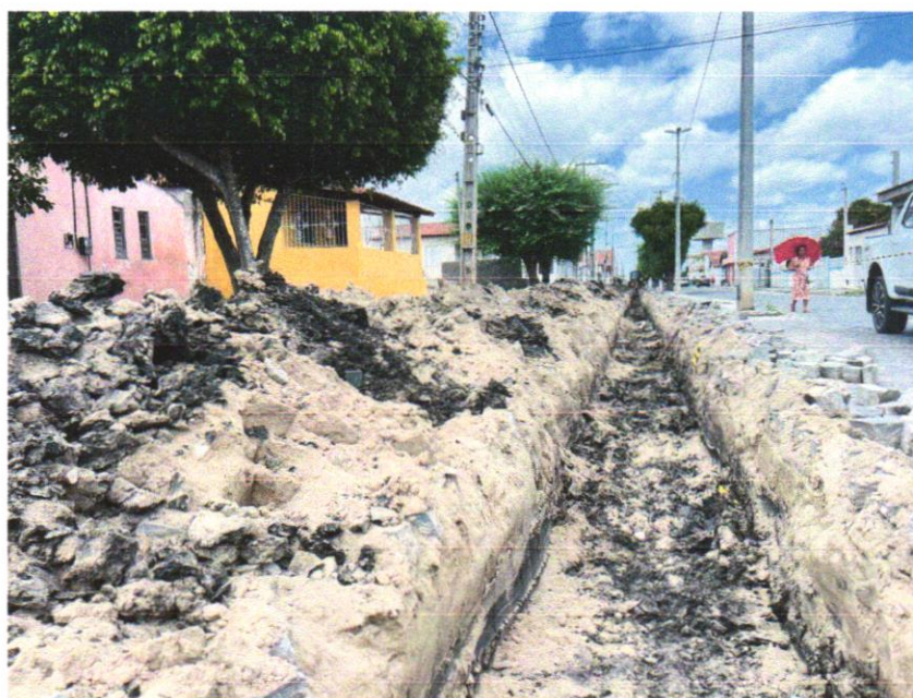
Foto 03 - ESCAVAÇÃO DE VALA
