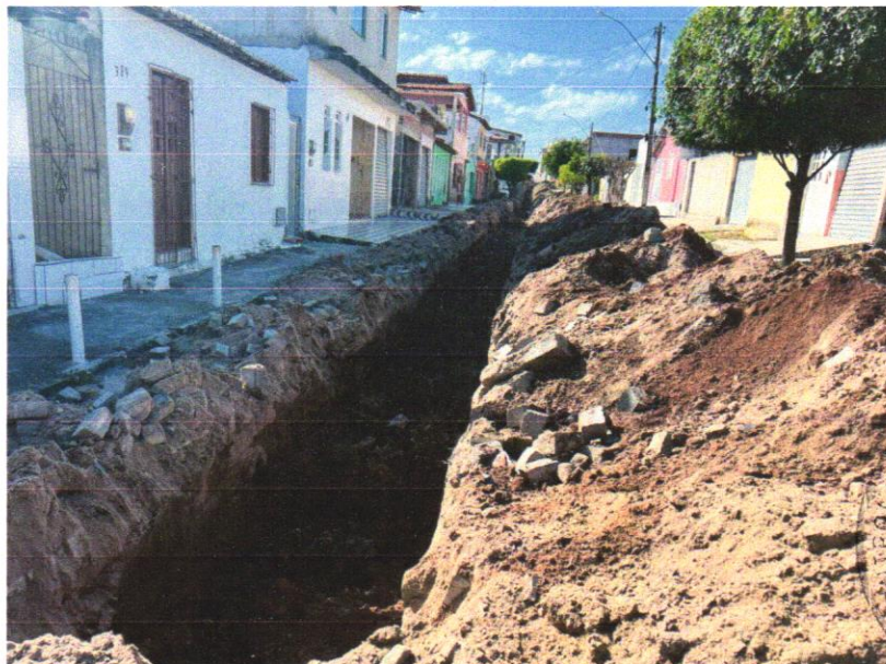
Foto 02 – ESCAVAÇÃO DE VALA
